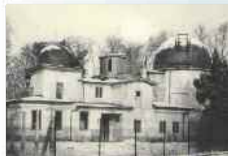
Pôvodná budova hurbanovskej hviezdárne pred jej rekonštrukciou. Fotografia je z roku 1960.
